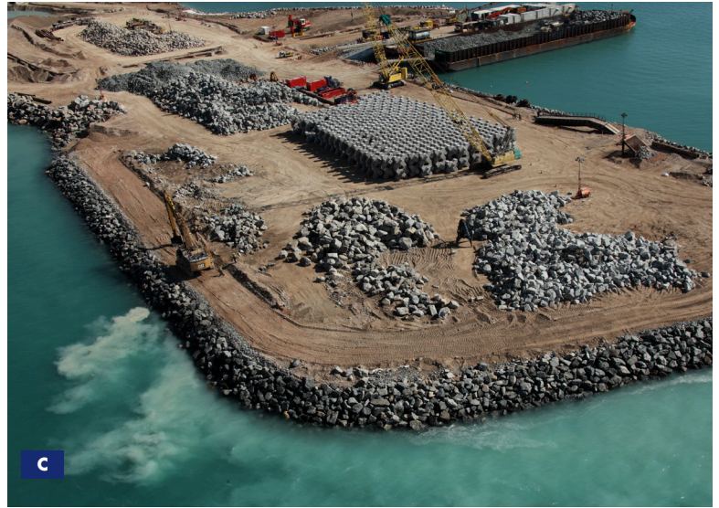
C Vista aérea de las obras de protección con rocas. D TSHD Gateway
