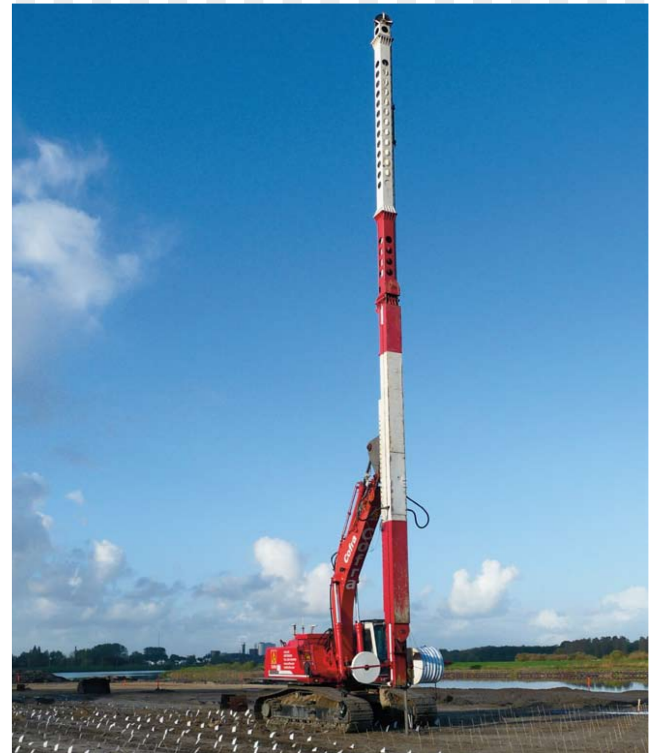
Установка вертикального дренажа на проекте строительства автодороги Westrandweg, Халфвег
