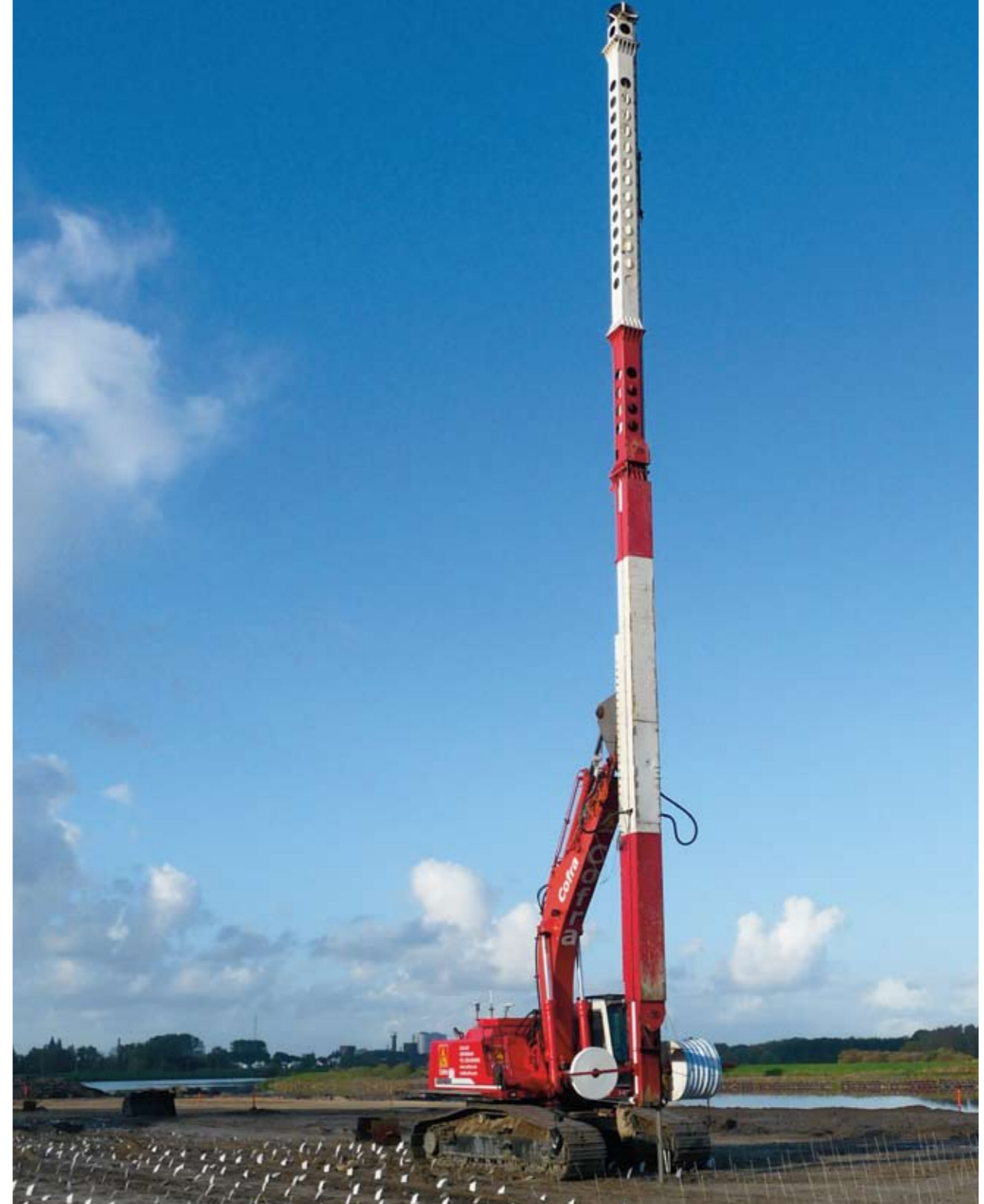
Installatie van verticale drainage op project Westrandweg, Halfweg
