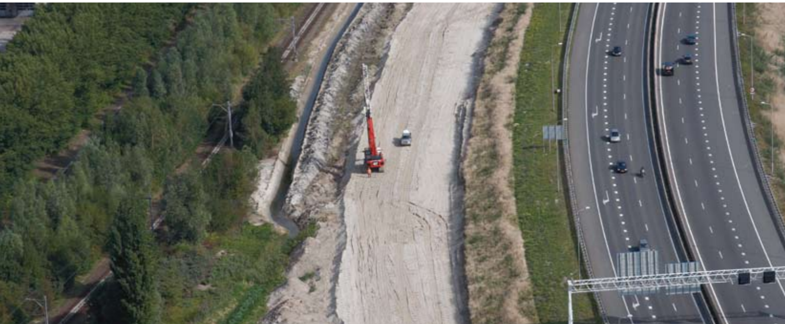
Aanleg van de infrastructuur met behulp van verticale drainage op project tweede Coentunnel, Amsterdam
