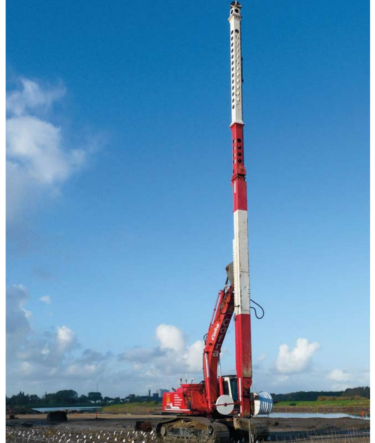
Construction du drainage vertical sur le projet Westrandweg, Halfweg, Pays-Bas
