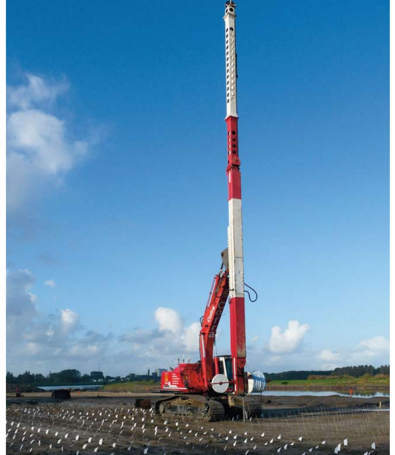
Instalación del drenaje vertical en el proyecto Westrandweg, Halfweg, Países Bajos
