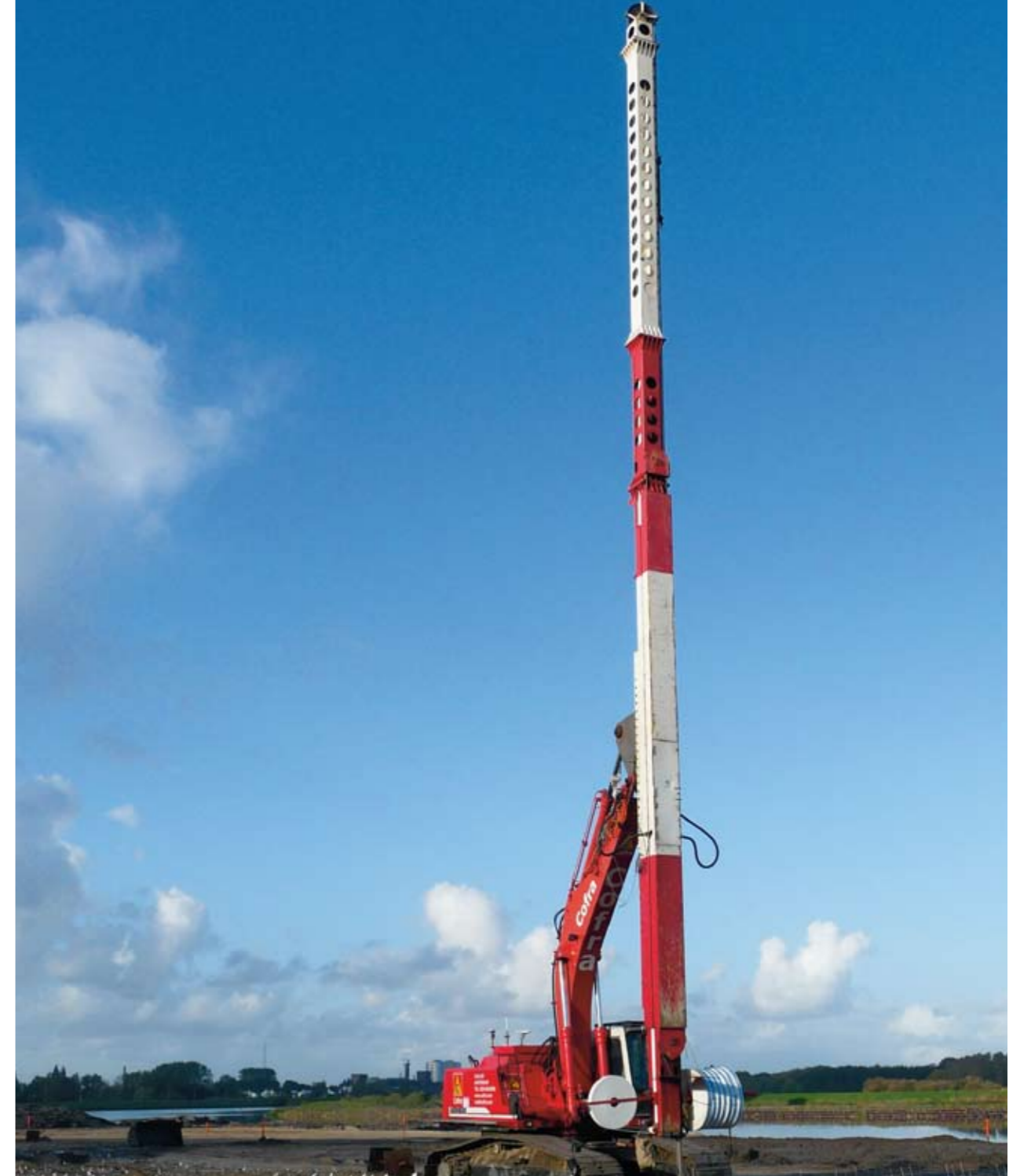
Einrichtung der Vertikaldränage am Weststrandweg-Projekt, Halfweg, Niederlande
