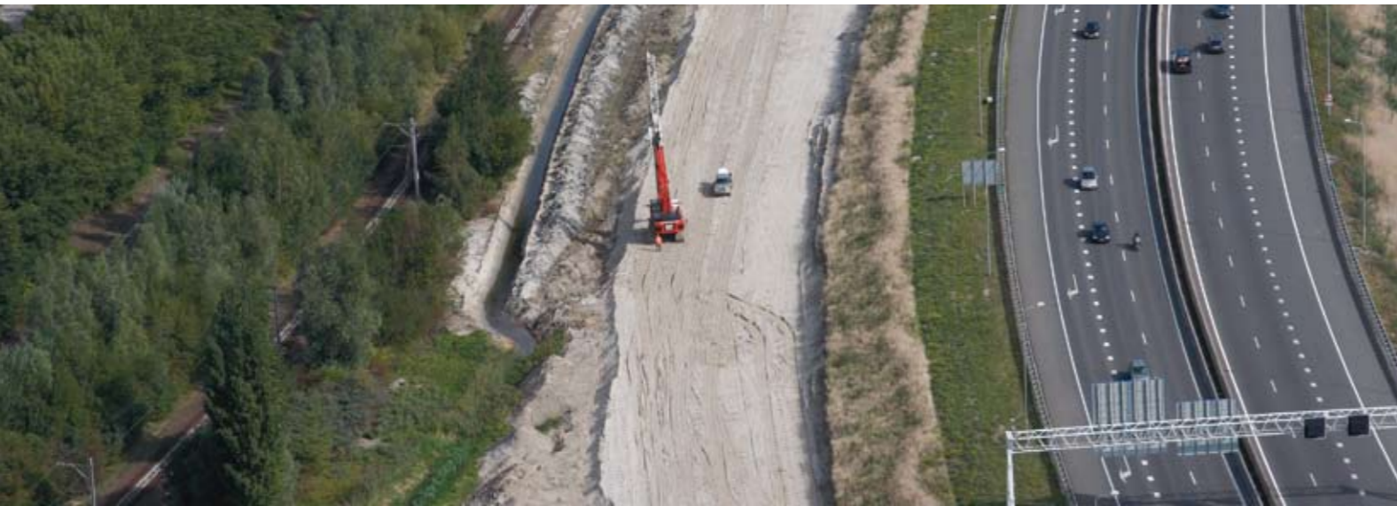
Einrichtung der Infrastruktur mithilfe der Vertikaldränage am Zweiten Coen-Tunnel-Projekt, Amsterdam, Niederlande
