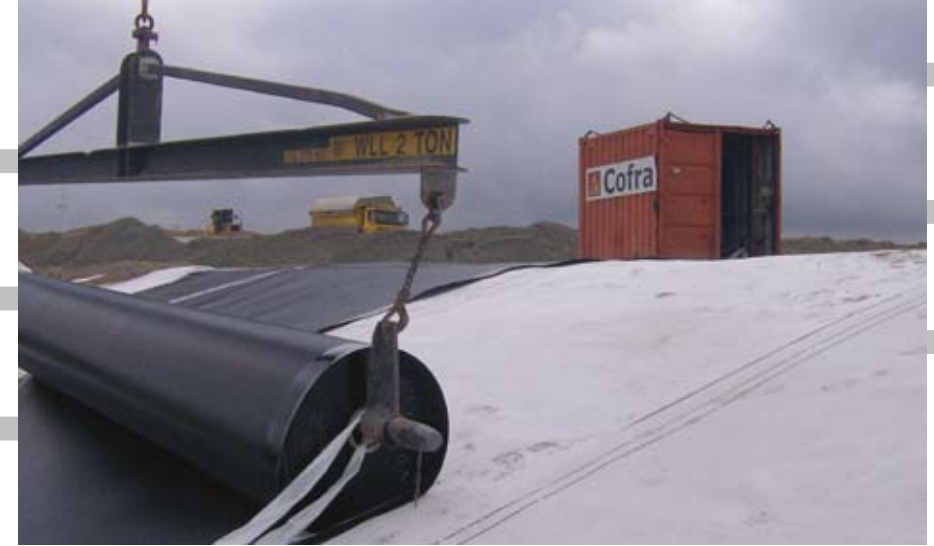
Folie wordt met behulp van een gelagerde evenaar uitgerold
