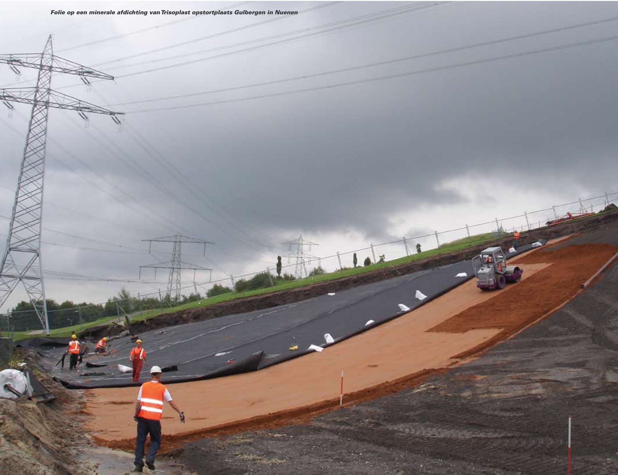
Folie wordt met behulp van een gelagerde evenaar uitgerold
