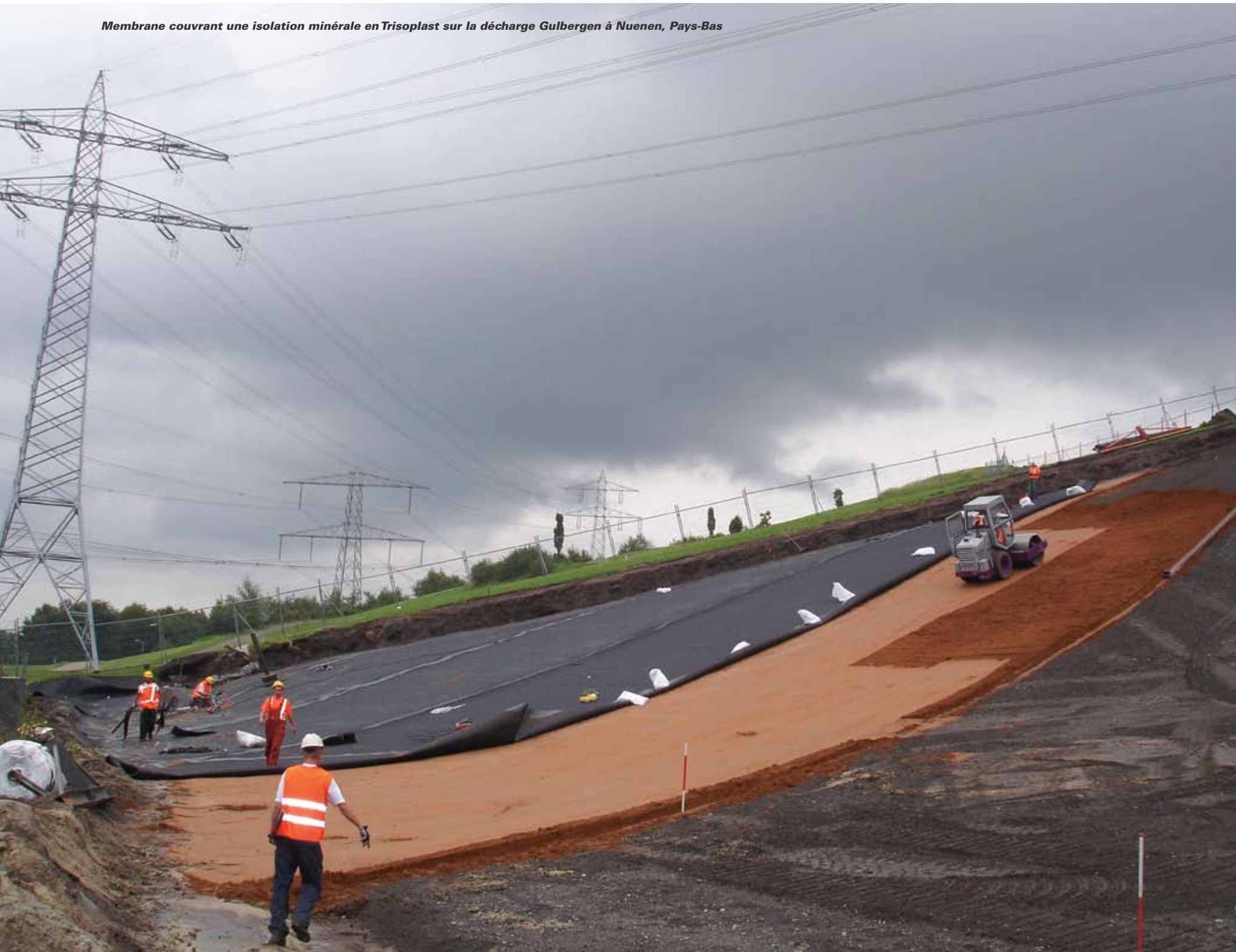
Déroulage de la membrane à l'aide d'un palonnier à roulement
