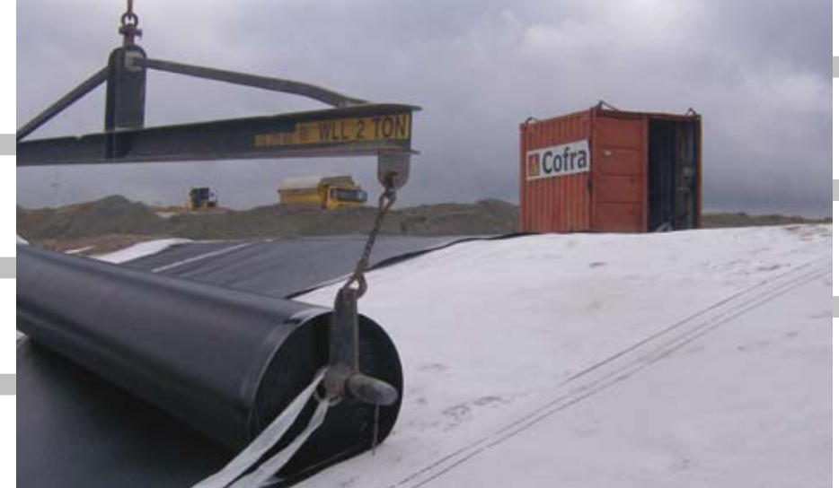
Déroulage de la membrane à l'aide d'un palonnier à roulement
