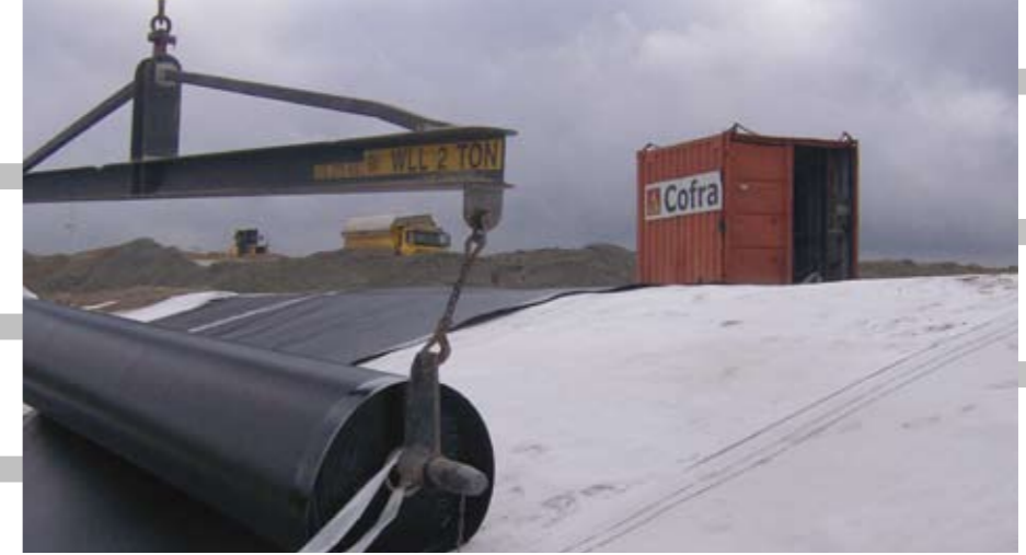
La membrana se desenrolla con la ayuda de un extendedor montado sobre rodapiés
