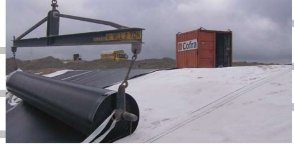
Die Membran wird mithilfe eines gelagerten Spreaders ausgerollt
