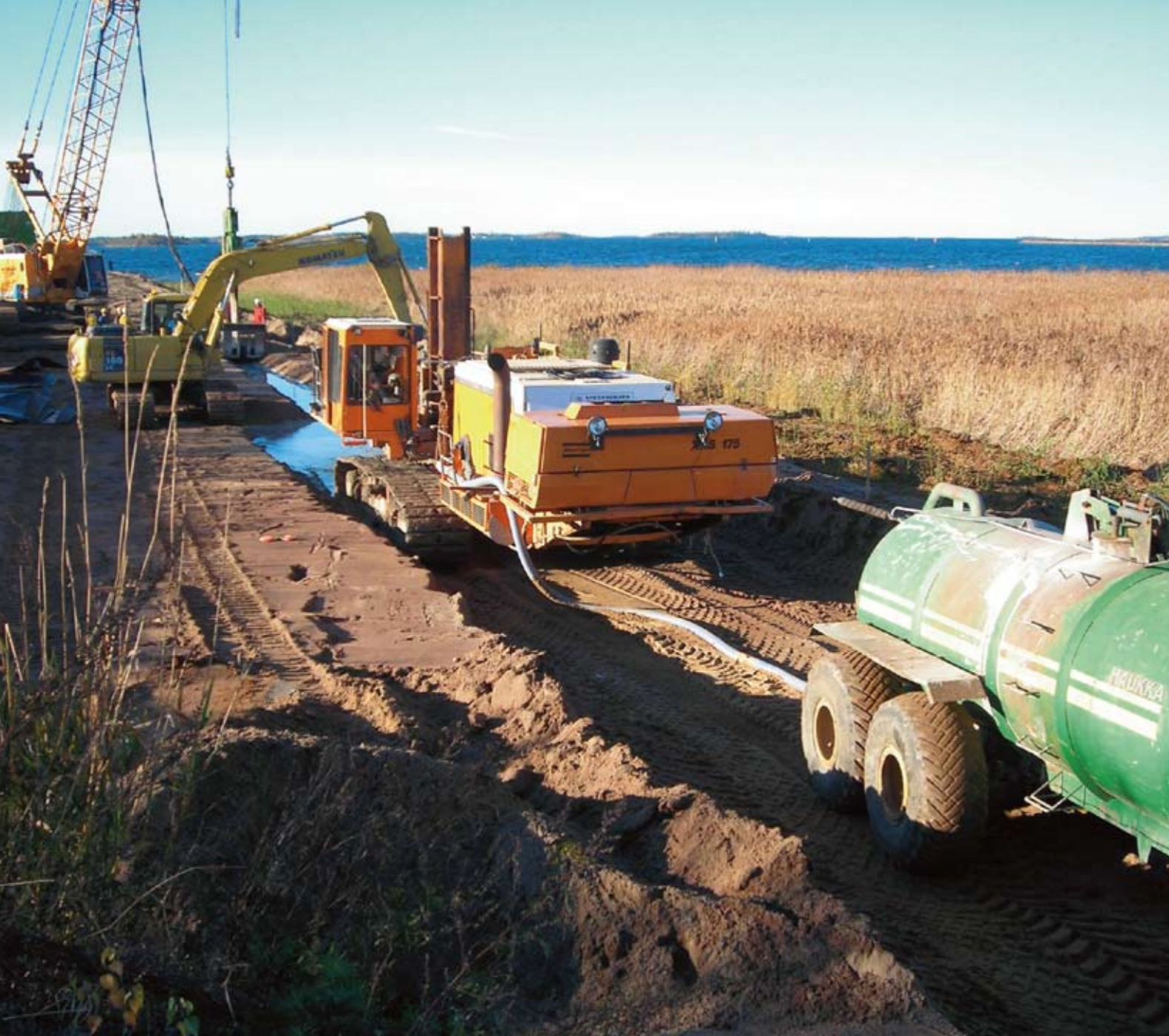
Instalación de Geolock en Kokkola, Finlandia
