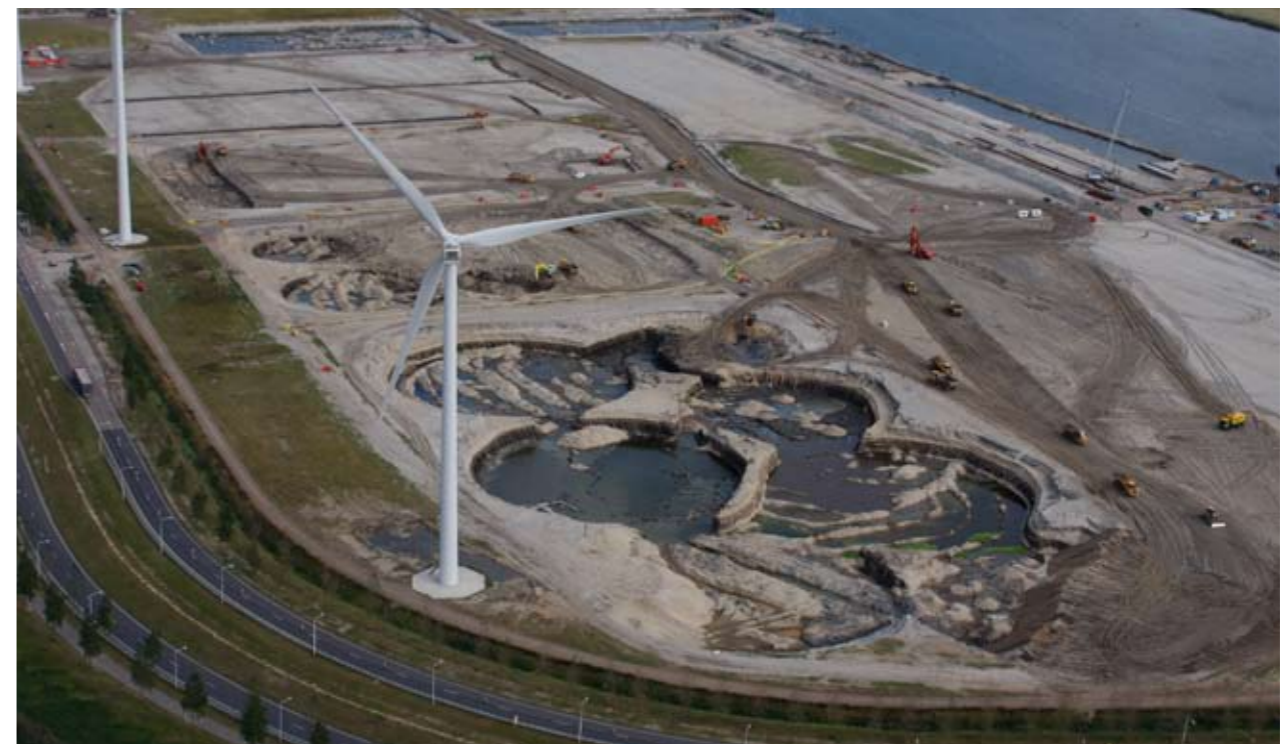
Земляные работы по отсыпке и уплотнению
