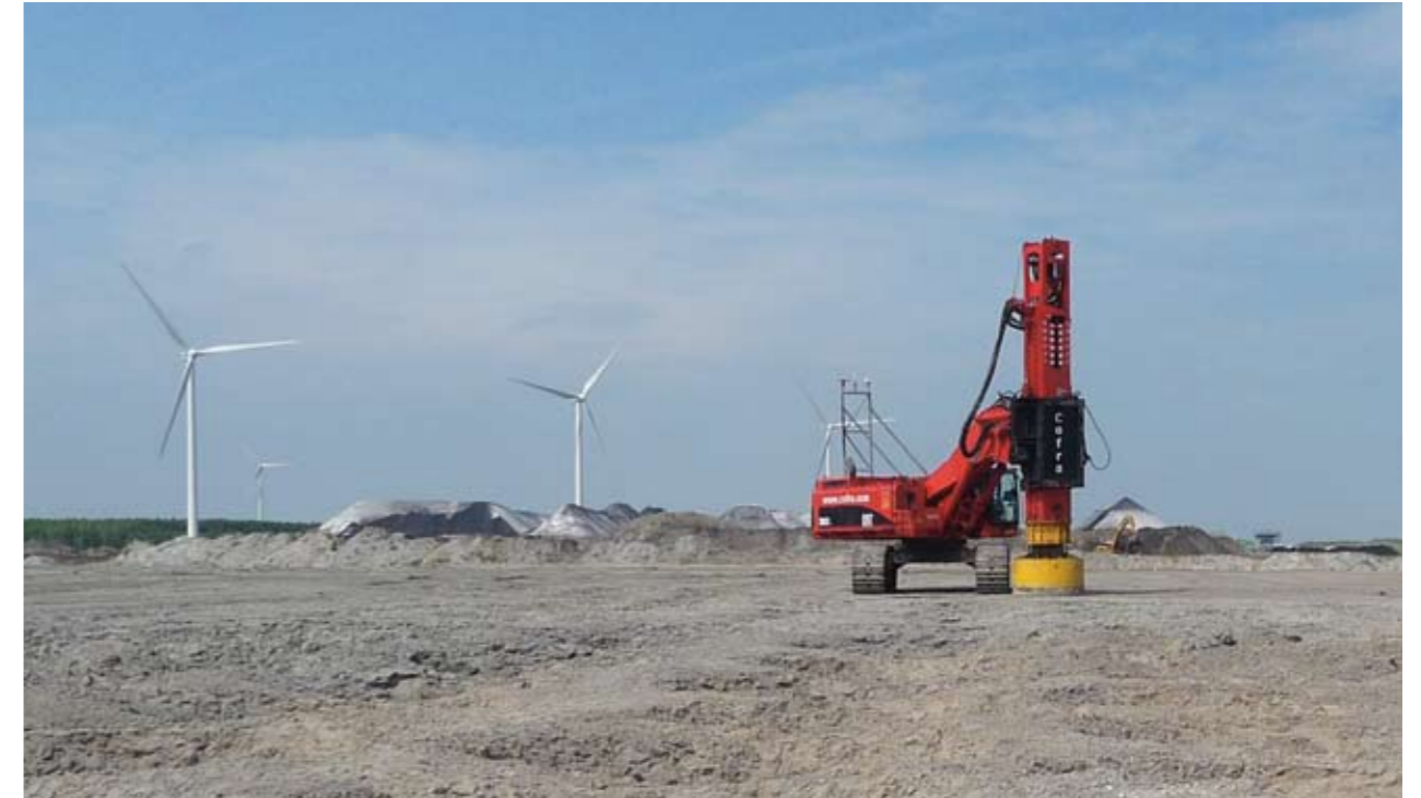
PPT avant et après compactage (sable avec moins de 2% de fines)
