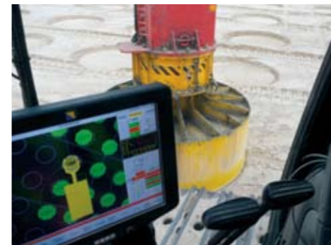
Supervisión mediante GPS
