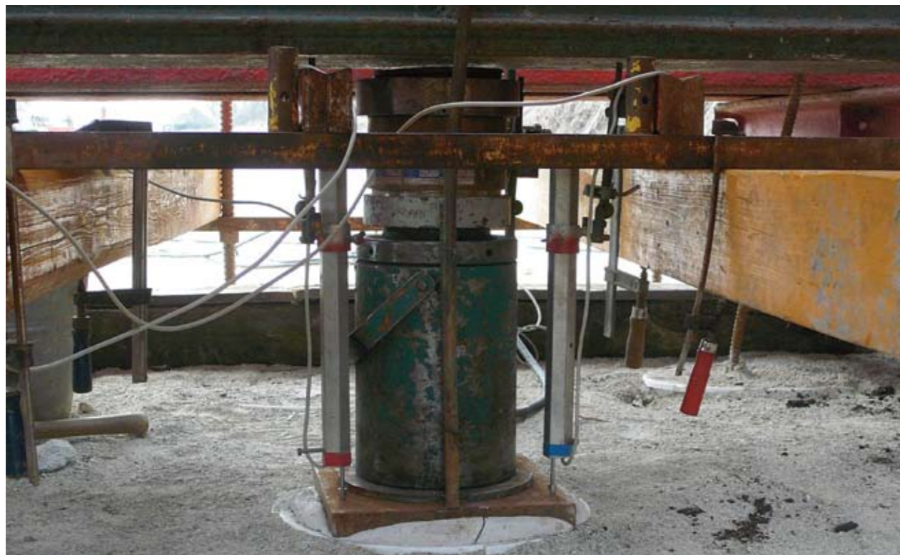
Prueba de carga de pilote AuGeo realizada en un proyecto en Eslovaquia
