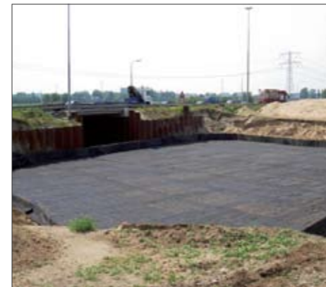
El colchón de la geomalla sin relleno granulado
