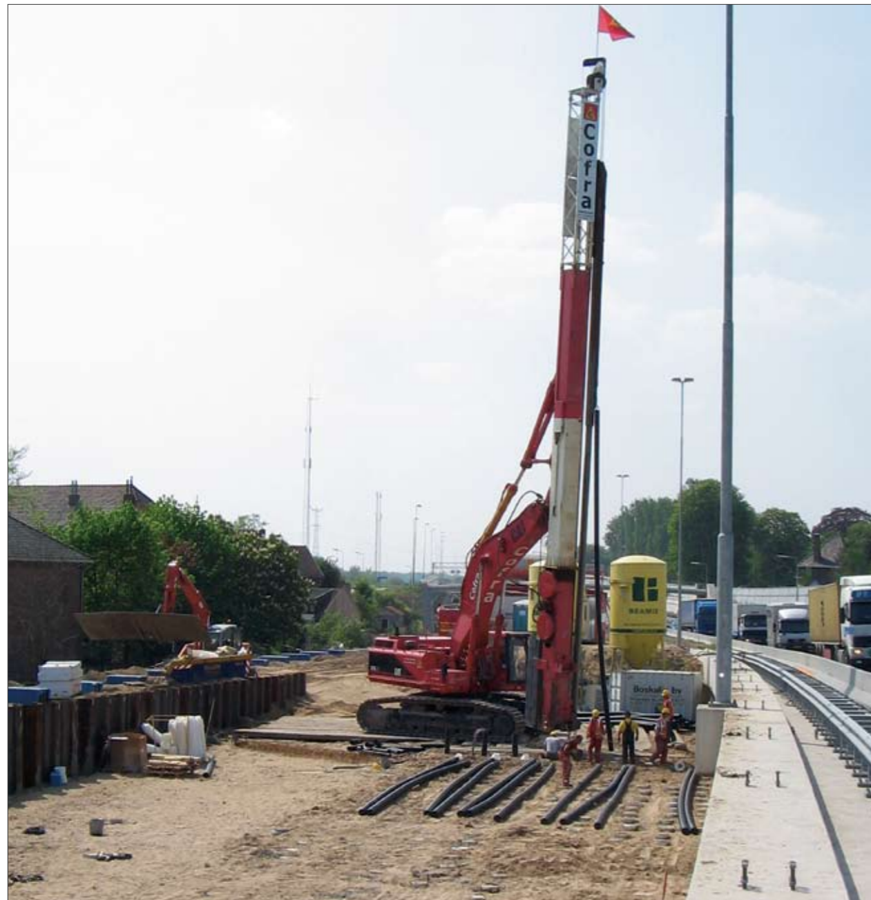
Einrichtung von AuGeo-Pfählen für die Süd-Richtungsfahrbahn der A15, Niederlande
