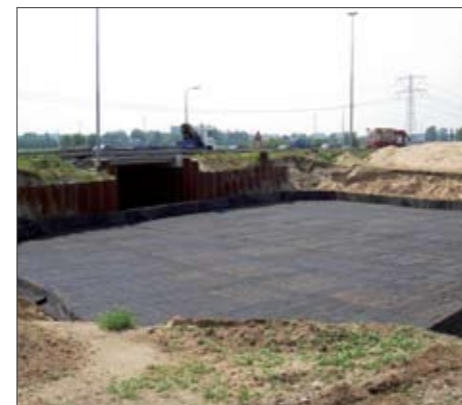
Die Geogittermatte ohne Granulatfüllung
